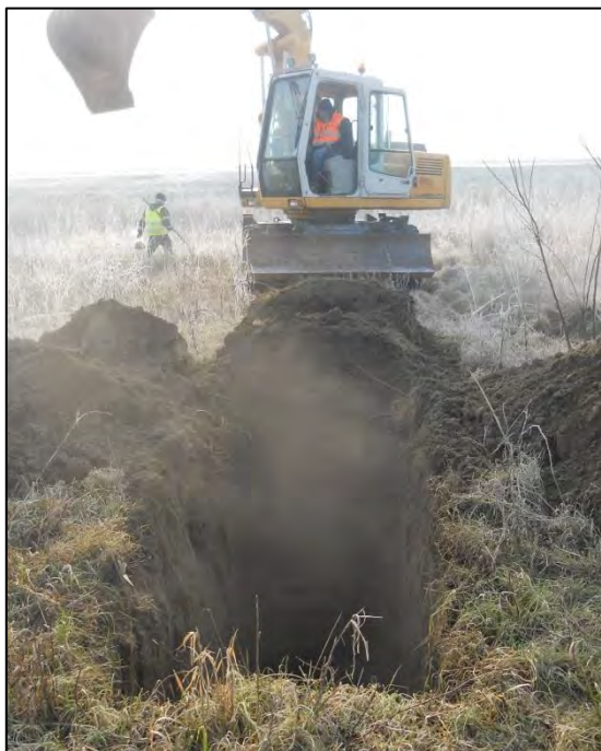
Figura 12 - Sondaggio T1 in fase di scavo
